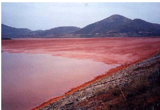
Les boues rouges issues de la transformation de la bauxite en alumine sont extrêmement toxiques.
